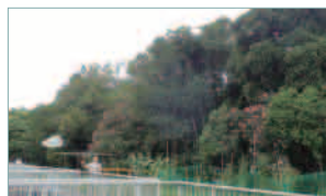
横浜市北部第二水再生センター
